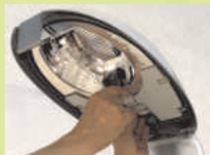
Nastavení svislé pozice světelného zdroje
